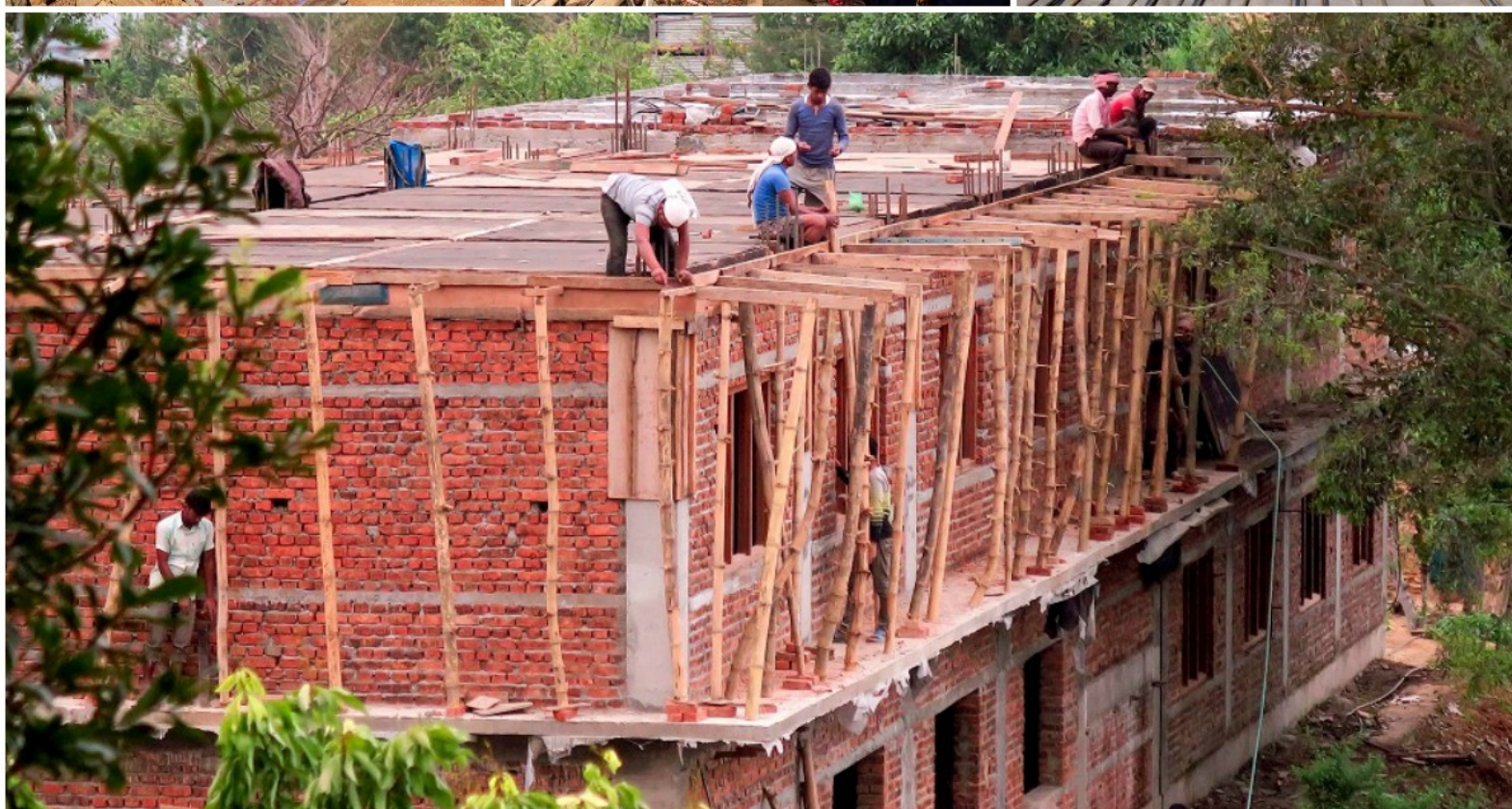
Budowa szkoły w marcu 2017 r., fot. M. Pastwa/ S. Jędernalik.
