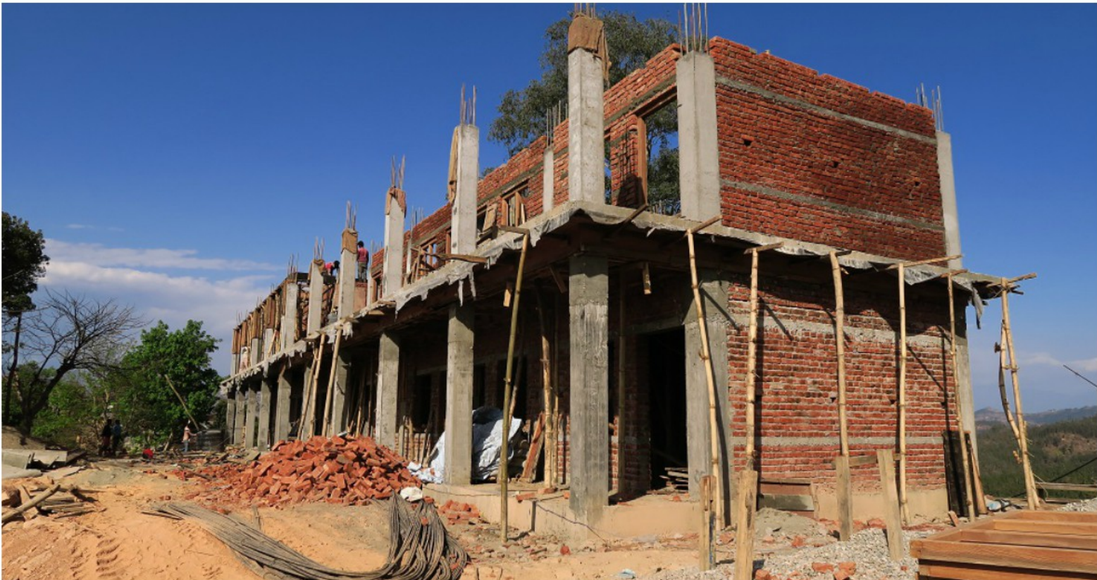
Budowa szkoły w lutym 2017 r., fot. M. Pastwa/ S. Jędernalik.
